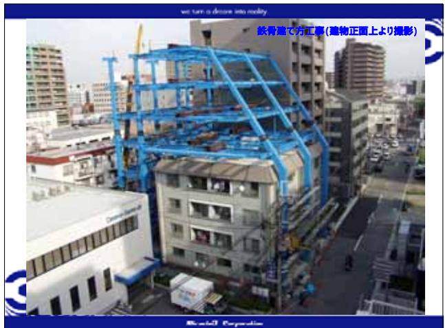
分を積み上げたのと同じやり方で、青い骨組みが3層建っています。7階建てに模様替えをして、共同住宅として現在実現しています。このような技術力を持ったミラクル構法として、今回実現させていただきたいと思います。
